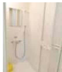
増設された学生寮シャワー室
