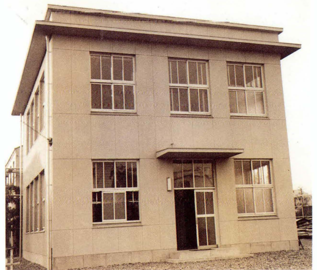
■完成した事務棟
