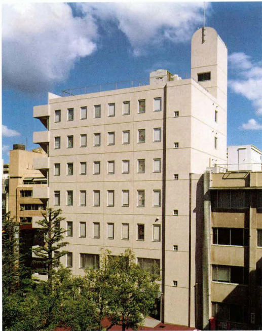
■4号館南西面全景
